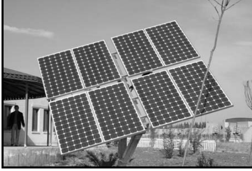
Şekil 2. Güneş izleyicili 1.4 kWp (8x175 W) güce sahip PV modül sistemine ait görüntüler
