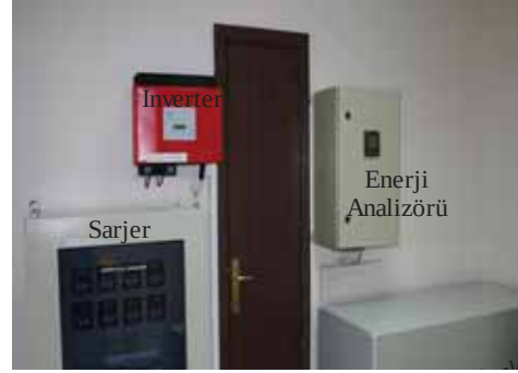
Şekil 2. Kütüphanede kurulu 3,5 kWp güçteki PV sistemin dış ve iç mekan fotoğrafları.
