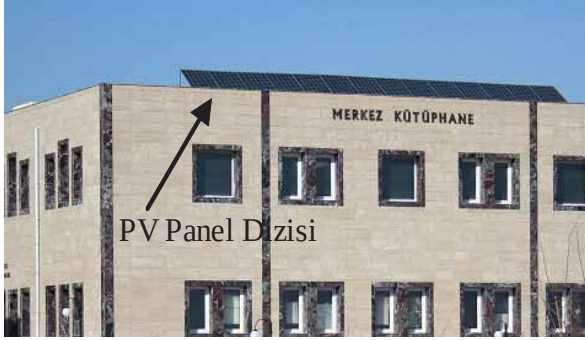
Şekil 2. Kütüphanede kurulu 3,5 kWp güçteki PV sistemin dış ve iç mekan fotoğrafları.
