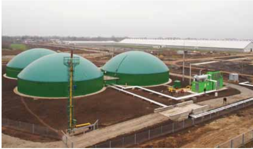
Şekil 3. Hayvansal atıklardan biyogaz ve biyogübre elde eden bir tesis için (a) çalışma prensibi, (b) örnek bir görüntü.
