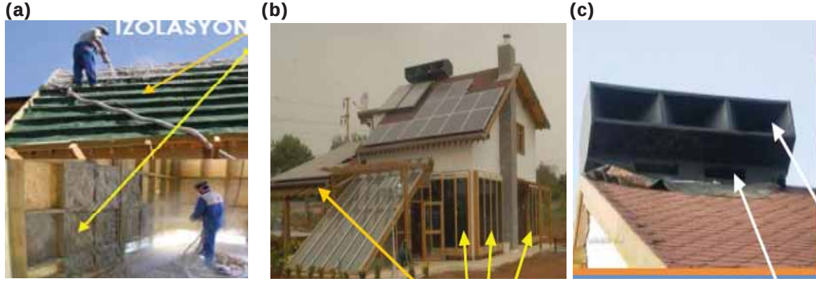
Şekil 15. Pasif sistemlerle iklimlendirme amaçlı yapı kabuğu ve ekipmanlar; (a) ahşap iskelet ve doğal yalıtım, (b) güneş duvarı, (c) rüzgar kepçesi ve venturi.
