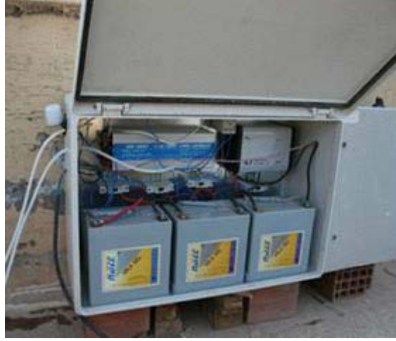
Gece sensörü, şarj kontrol ve Bataryalar
