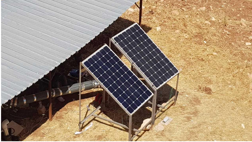
Şekil 3. THID ile soğutulan PV sistem
