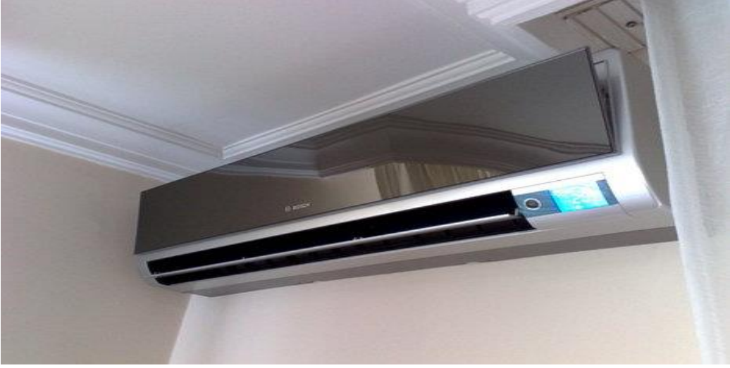
Şekil.5.19. Split - Duvar tipi cihazlar
