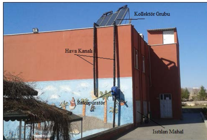
Şekil-2 Güneş enerjili, toprak-hava ısı değiştiricili ve reküperatörlü ısıtma sistemi
