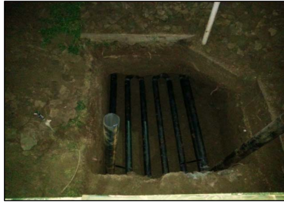
Şekil-4 Toprak-hava ısı değiştiricisinin toprağa yerleştirilmiş hali
