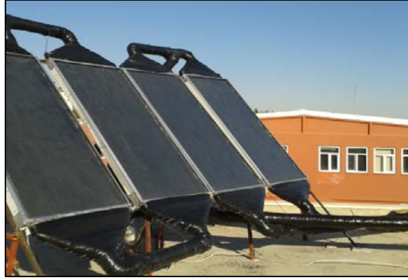
Şekil-3 Seri-paralel havalı güneş kolektörü grubu ve yalıtımlı hava kanalı
