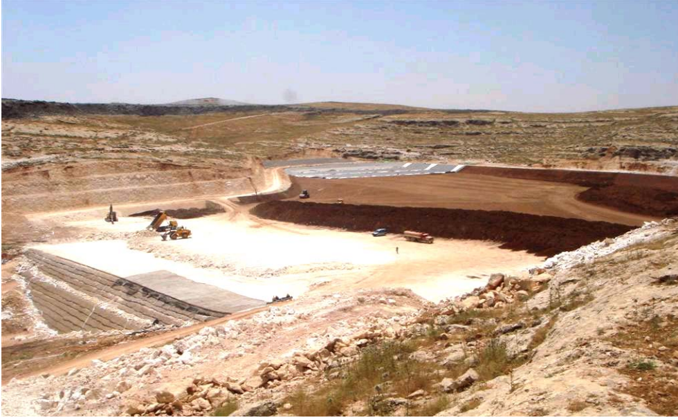
Şekil 2. Düzenli Depolama Tesisi İnşaatından Genel Görünüm
