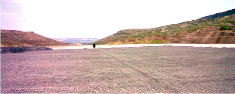
Şekil 3. Düzenli Depolama Tesisi İşletme Aşamasından Genel Görünüm
