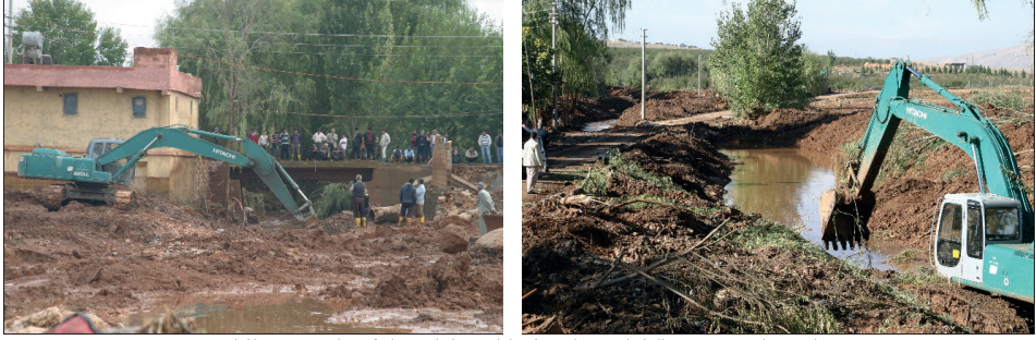
Şekil 31. Şanlıurfa/Yaylak Beldesi taşkın ıslah/koruma çalışmaları
