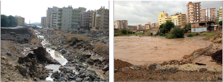
Şekil 27. Karaköprü Deresi taşkın koruma öncesi
