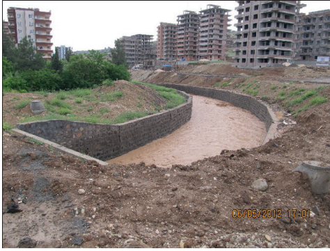
Şekil 28. Karaköprü Deresi taşkın ıslah çalışması sonrası
