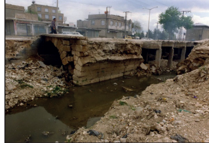
Şekil 15. Kısas (Beykapısı) Köprüsünün yakın zamanlı görseli (Kürkçüoğlu, 2011). (Köprü, 1997 yılında Karakoyun yenileme projesi çalışmaları esnasında yıkılmıştır.)
