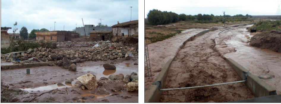
Şekil 25. Şanlıurfa Harran ve bazı sulama kanallarında 2006 taşkını esnası durum
