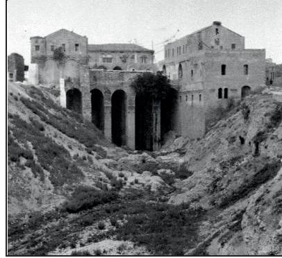
Şekil 17. Hacı Kamil Köprüsü (Uyanık, 1951)
