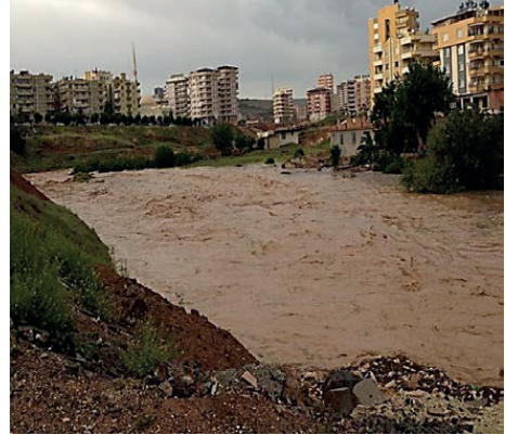
Şekil 22. Ş.Urfa/K.Köprü ilçesi bir taşkın esnası (AFAD, 2012).
