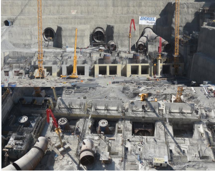
Şekil 19. Ilisu barajı santral binası çalışmaları
