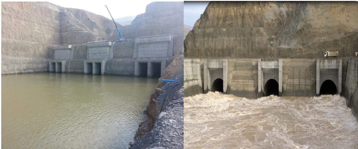
Şekil 13. Ilisu Barajı Derivasyon tünelleri Giriş ve Çıkış Yapıları
