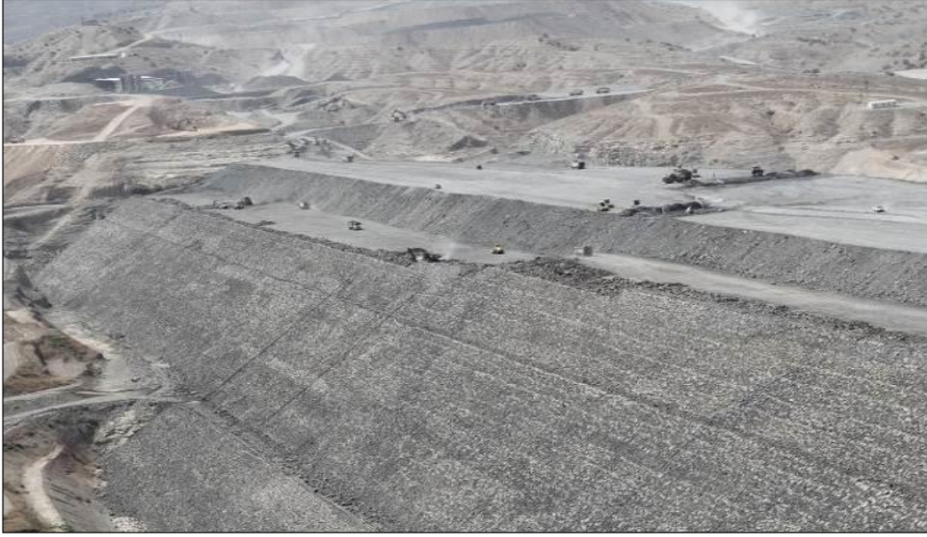
Şekil 5. Gövde dolgu çalışmaları
