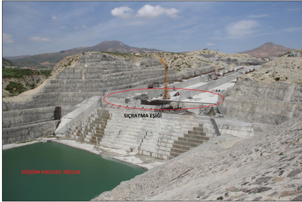
Şekil 10. Dolusavak Sıçratma Eşiği ve Düşüm Havuzu
