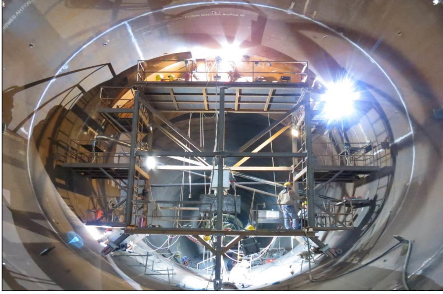
Şekil 15. Ilisu Barajı Dipsavak çalışmaları
