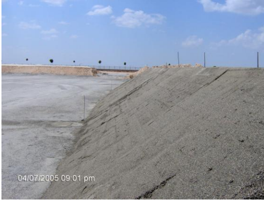
Resim 13.14: Tüm gölet tabanının ve şevlerin kum serim işlerinin tamamlanması
