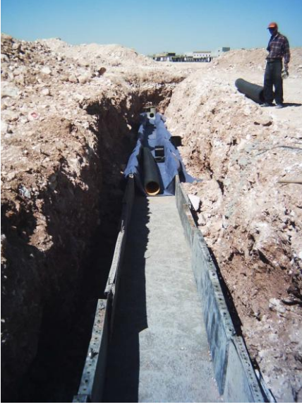
Resim 5.6: Drenaj borularının yerleştirilmesi ve korunması.
