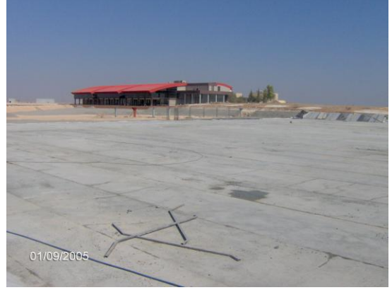
Resim 17.18: Gölet tabanında sızdırmazlık için izolasyon miktarlarının ve ısı etkisiyle oluşan potlanmanın takibi.
