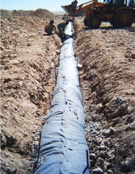
Resim 7.8: drenaj borularının sarılması ve etrafının kapatılması.
