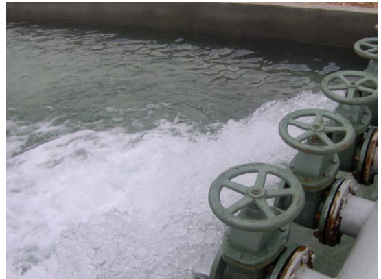
Resim 21.22: Betonun korunması ve bekleme süresi sonrası vanaların açılması.
