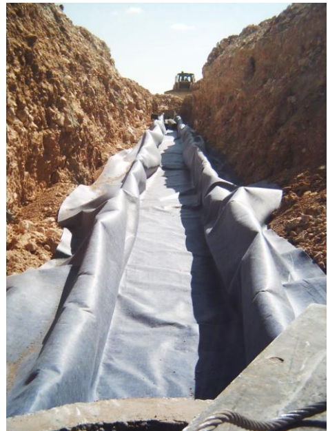
Resim 3.4: Drenaj kanallarının kazısı ve boru yuvalarının hazırlanması.
