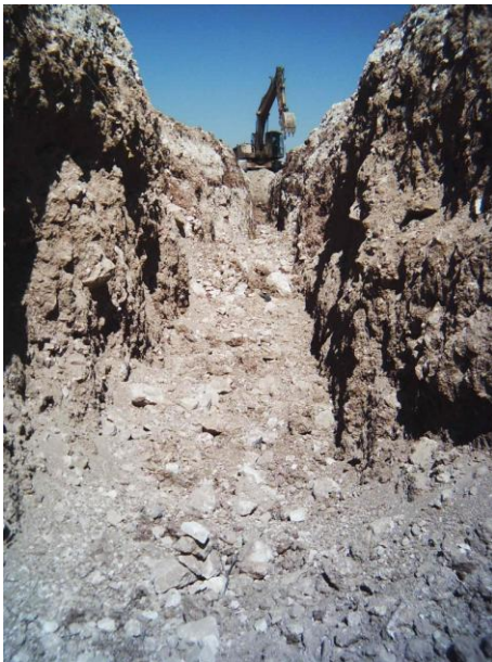
Resim 3.4: Drenaj kanallarının kazısı ve boru yuvalarının hazırlanması.
