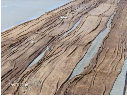
Resim 19.20: Gölet taban ve şevlerinin betonlanması.
