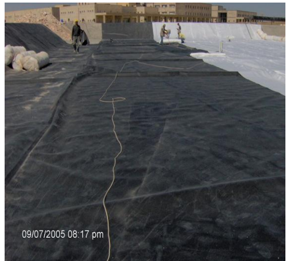
Resim 15.16: Jeotekstil ve jeomembranların serimi ve eklenmesi işlemleri.
