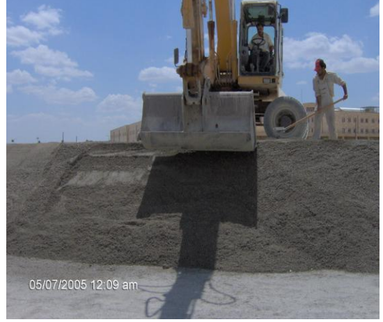
Resim 11.12: Şevlerde kum serimi ve üst yapı beton kalınlığının tayini.
