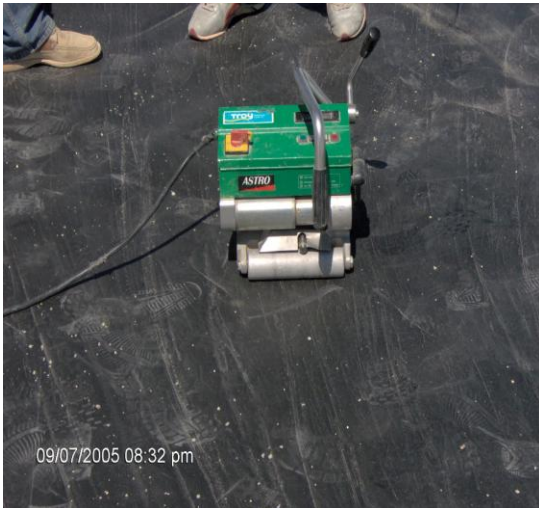
Resim 15.16: Jeotekstil ve jeomembranların serimi ve eklenmesi işlemleri.
