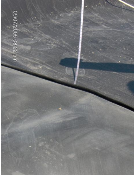
Resim 17.18: Gölet tabanında sızdırmazlık için izolasyon miktarlarının ve ısı etkisiyle oluşan potlanmanın takibi.
