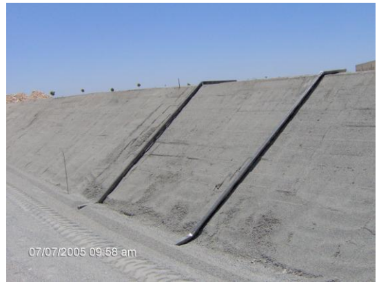
Resim 13.14: Tüm gölet tabanının ve şevlerin kum serim işlerinin tamamlanması
