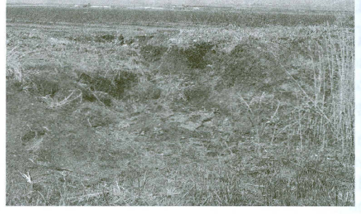
Şekil 4.18. Urfa drenaj kanalı şev akmaları ve bitki oluşumu
