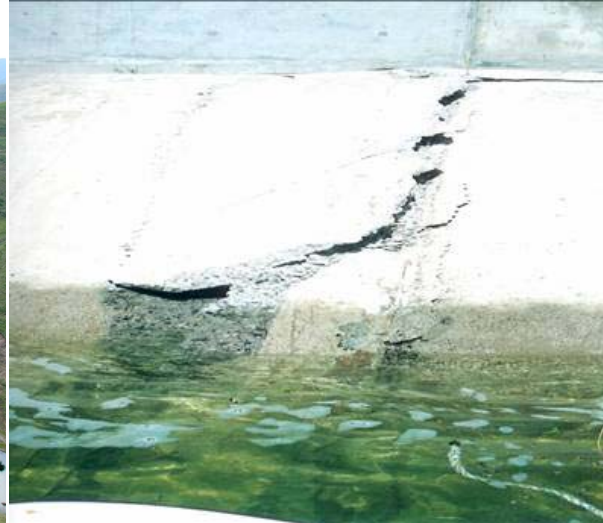
Şekil 5: Mohale Barajı ve beton kırılmaları (Anonymous 2013c)
