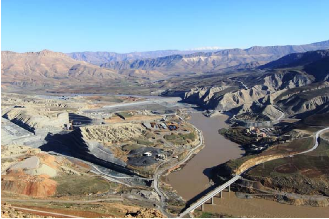
Şekil 4: Ilisu Barajı İnşaat Aşaması Genel Görünüm
