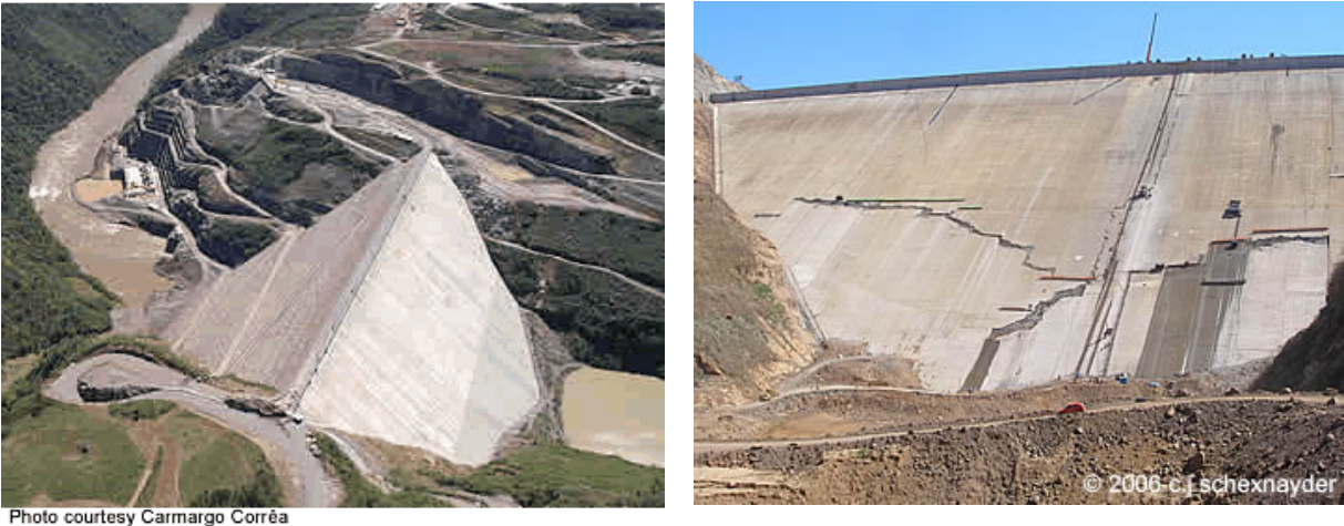
Şekil 3: Campos Novos Barajı ve beton kırılmaları (Schexnayder, 2013)
