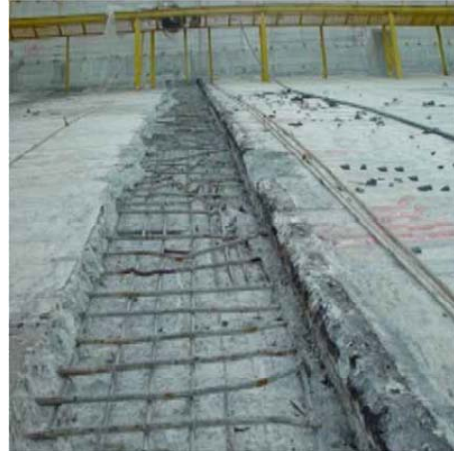
Şekil 4:TSQ 1 (Tianshengqiao) Barajı ve beton kırılmaları
