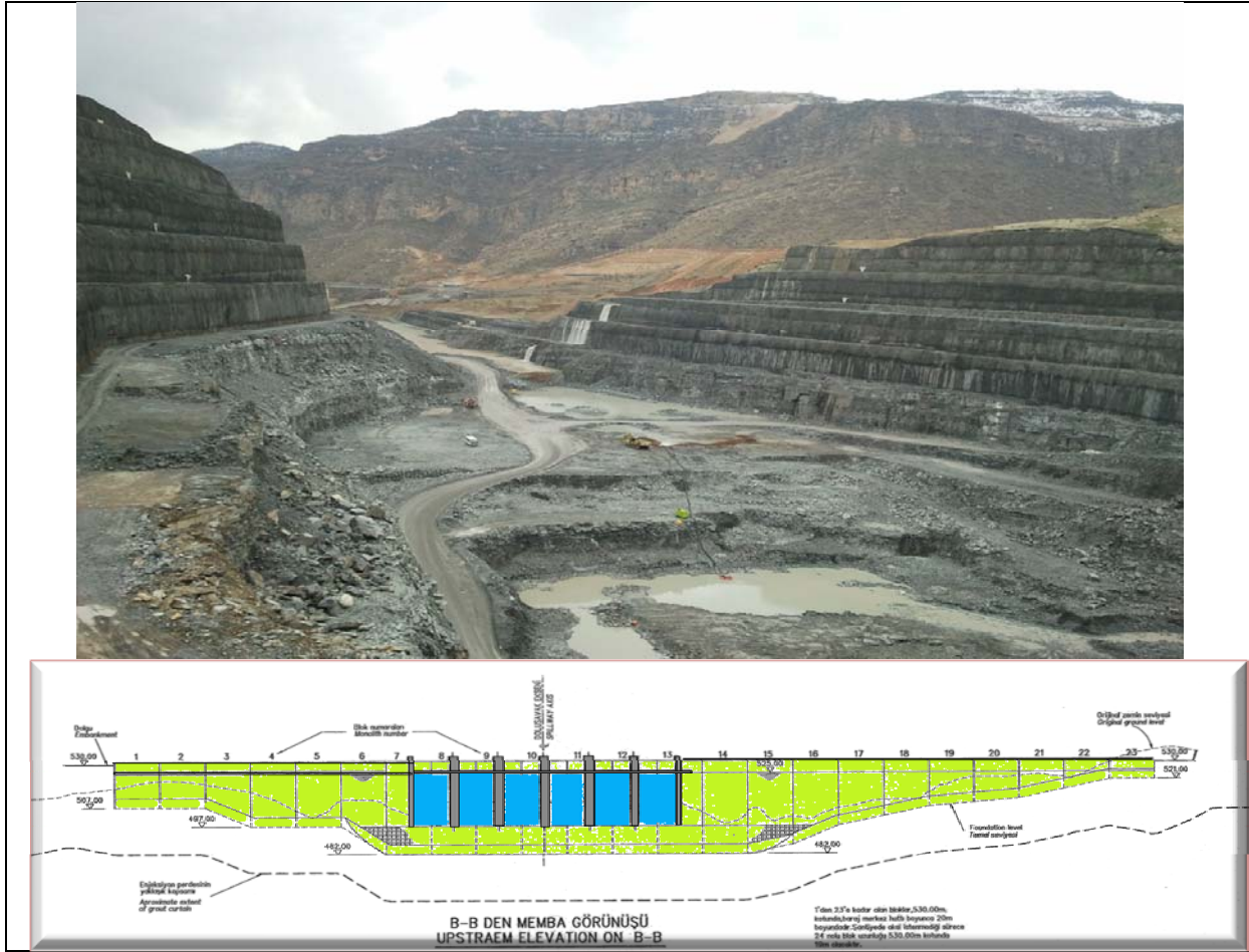
Şekil 6. Ilisu Barajı Dolusavak Kesiti ve İnşa Aşaması
