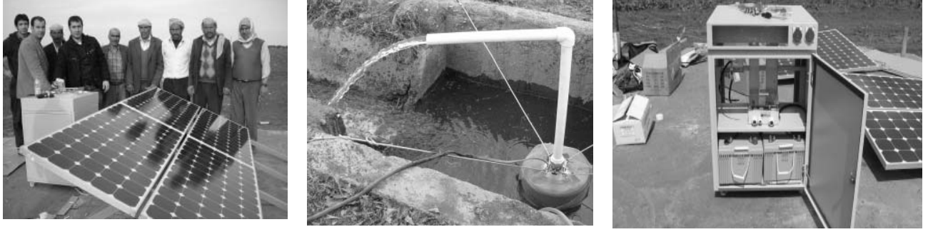
Şekil 5. PV-pompalama sistemi elemanları
